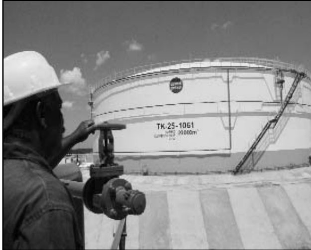
Estos tanques están dotados de modernos sistemas tecnológicos y contraincendios.
